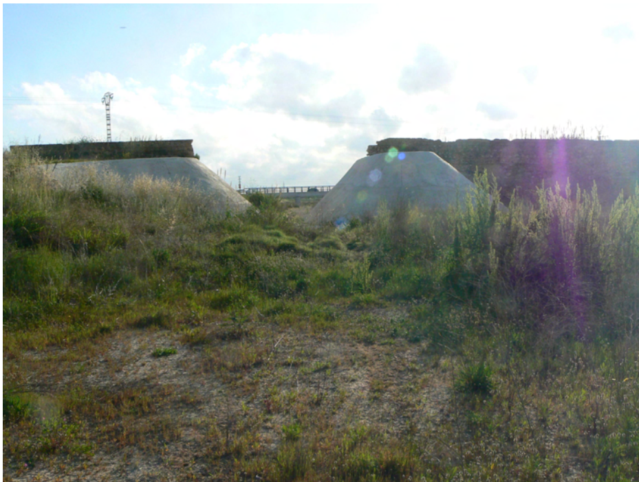
Foto nº 3.2. Vista, hacia aguas abajo, de la apertura en la mota con muro, en el nuevo cauce de La Gallinera (20-4-15)
