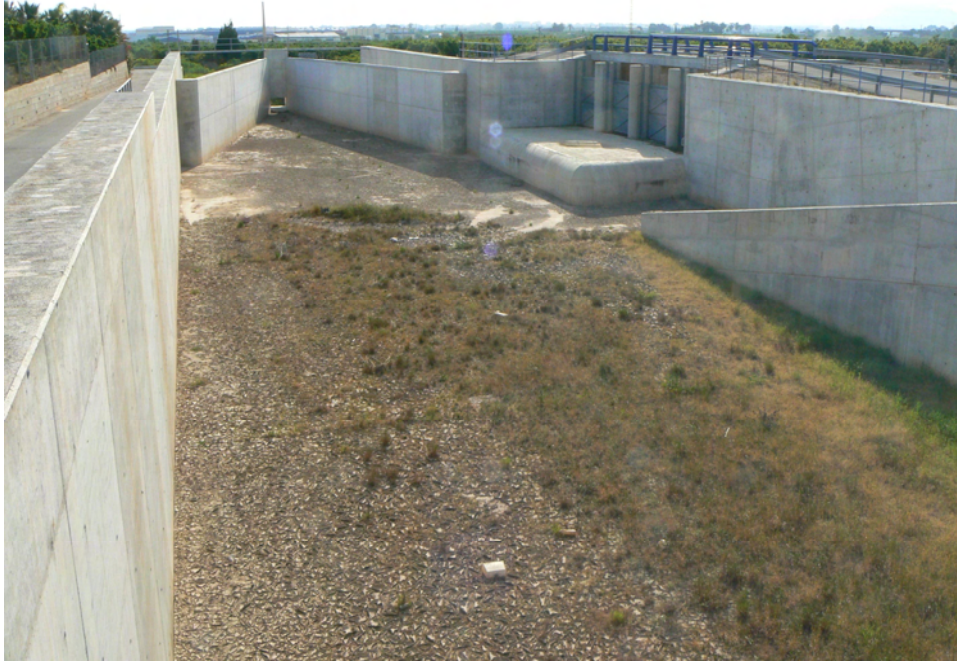
Foto nº2.1. Vista, hacia aguas abajo, del sistema de laminación y derivación del Alfadali (20-4-15)
