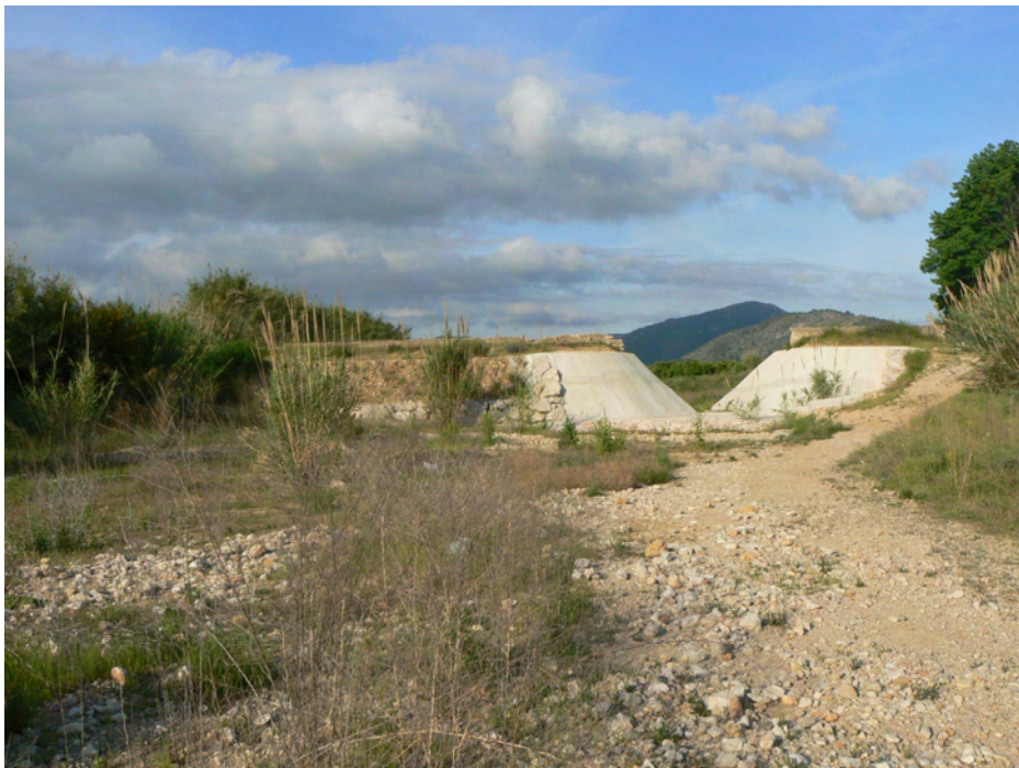
Foto nº 3.4. Vista, hacia aguas arriba, de la apertura en la mota con muro, en el nuevo cauce de La Gallinera (20-4-15)
