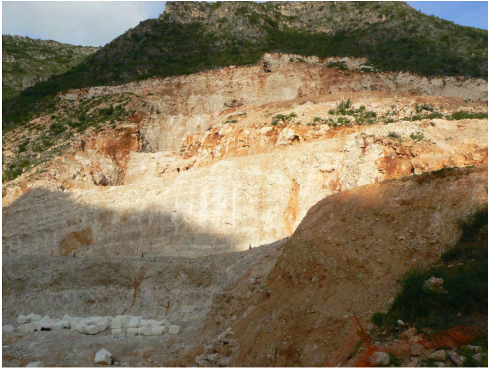
Foto nº 1.2. Vista de la margen izquierda de la excavación para la presa en La Gallinera (20-4-15)
