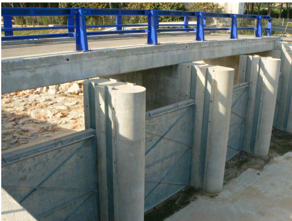
Foto nº 2.4. Vista, detalle, de las compuertas instaladas en la derivación del Alfadali (20-4-15)
