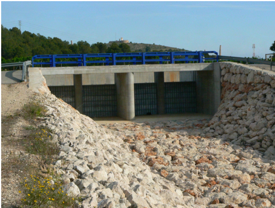
Foto nº2.3. Vista, hacia aguas arriba, de las compuertas instaladas en la derivación del Alfadali (20-4-15)
