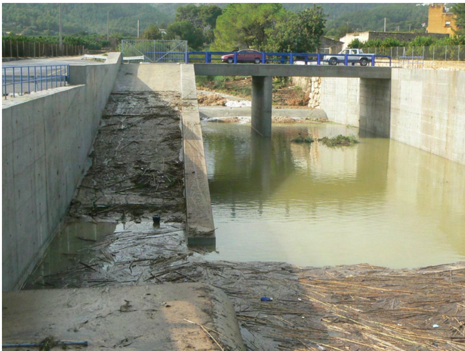
Foto nº4.2. Vista, hacia aguas arriba, del sistema de laminación y derivación del Alfadalí (14-11-12)
