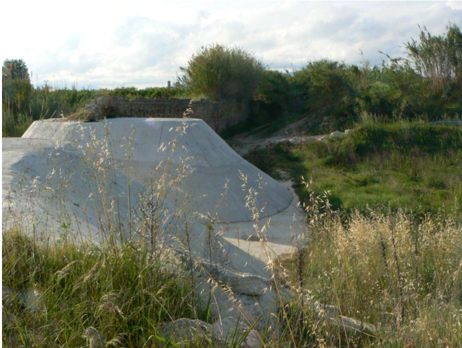
Foto nº 3.3. Vista detalle, hacia aguas abajo, de la apertura en la mota con muro, en el nuevo cauce de La Gallinera (20-4-15)
