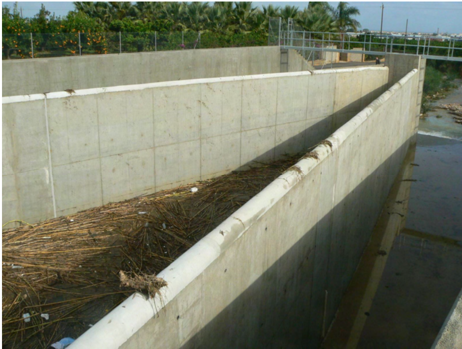
Foto nº4.5. Vista, hacia aguas abajo, del muro de retención del sistema de laminación y derivación del Alfadalí (14-11-12)
