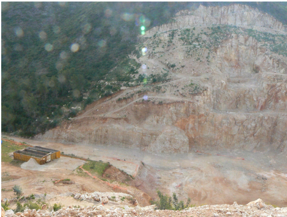
Foto nº 1.2. Vista de la margen derecha de la excavación para la presa en La Gallinera (20-4-15)
