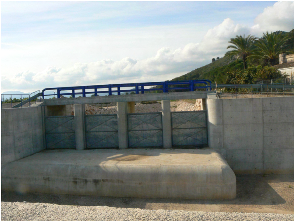
Foto nº2.2. Vista, hacia aguas abajo, de las compuertas instaladas en la derivación del Alfadali (20-4-15)
