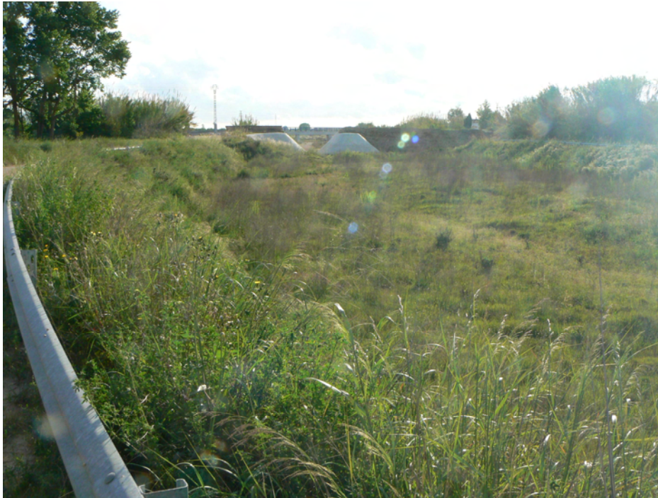
Foto nº 3.1. Vista, hacia aguas abajo, de la apertura en la mota con muro, en el nuevo cauce de La Gallinera (20-4-15)
