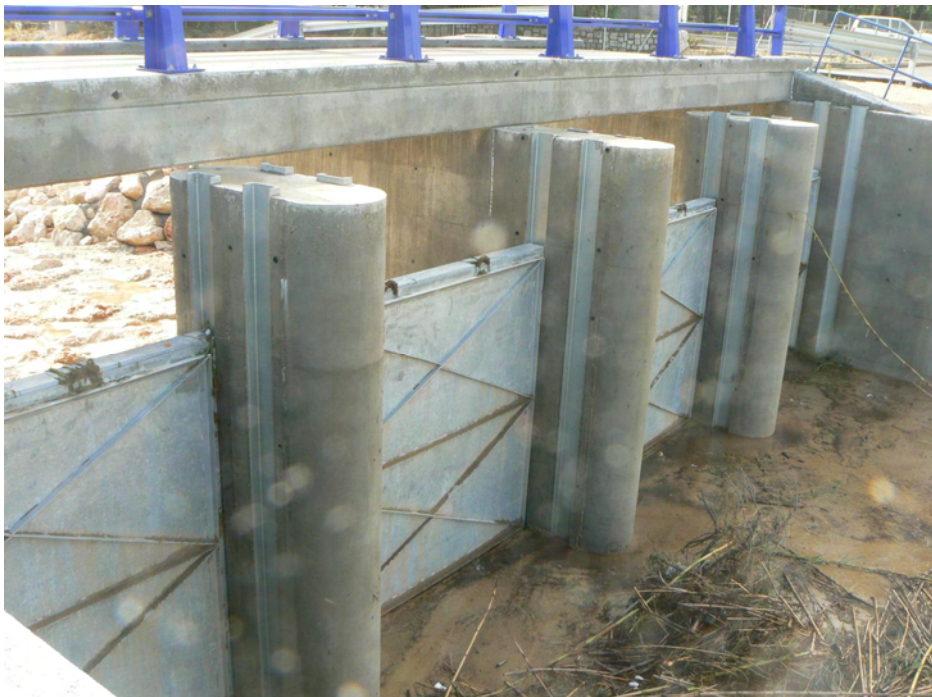
Foto nº4.4. Vista de las compuertas instaladas en la margen derecha de la derivación del Alfadali (14-11-12)
