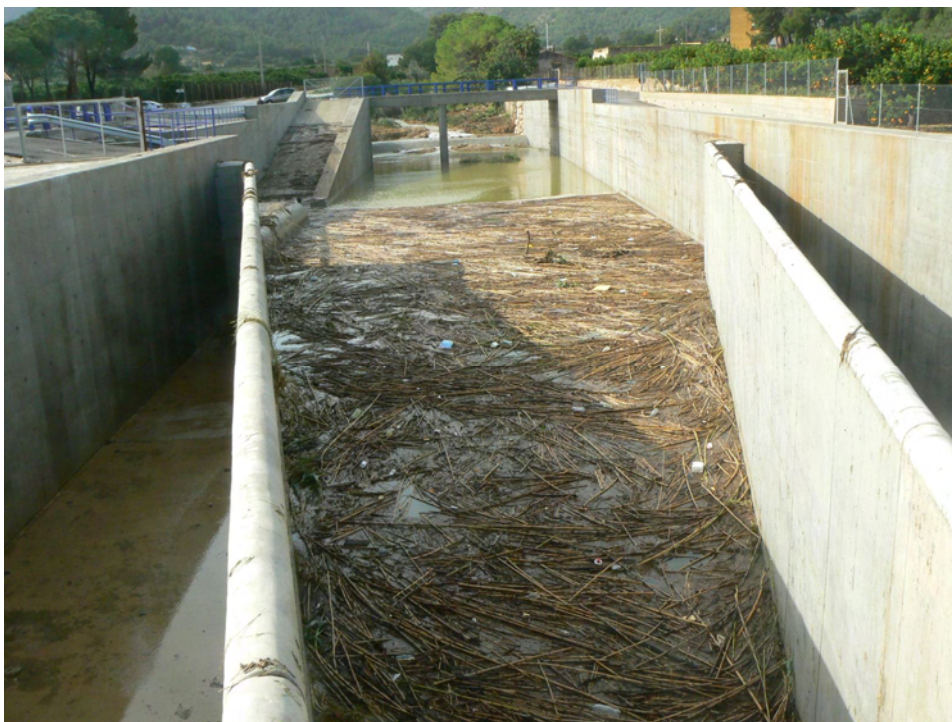
Foto nº4.6. Vista, hacia aguas arriba, del muro de retención del sistema de laminación y derivación del Alfadalí (14-11-12)
