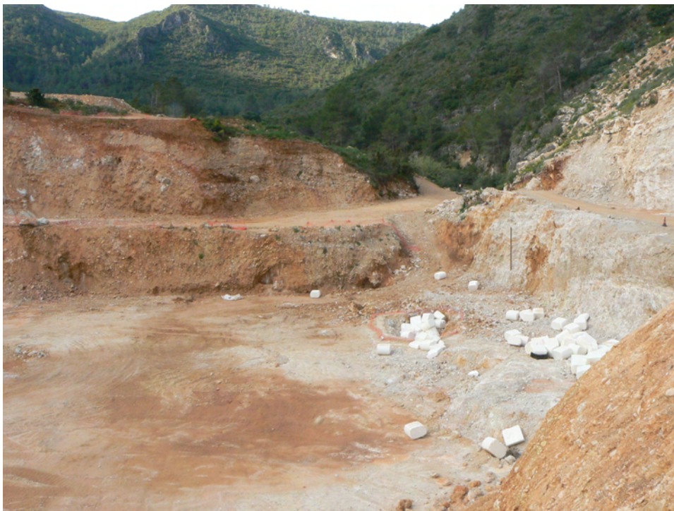
Foto nº 1.1. Vista, hacia aguas arriba, de la excavación para la presa en La Gallinera (20-4-15)
